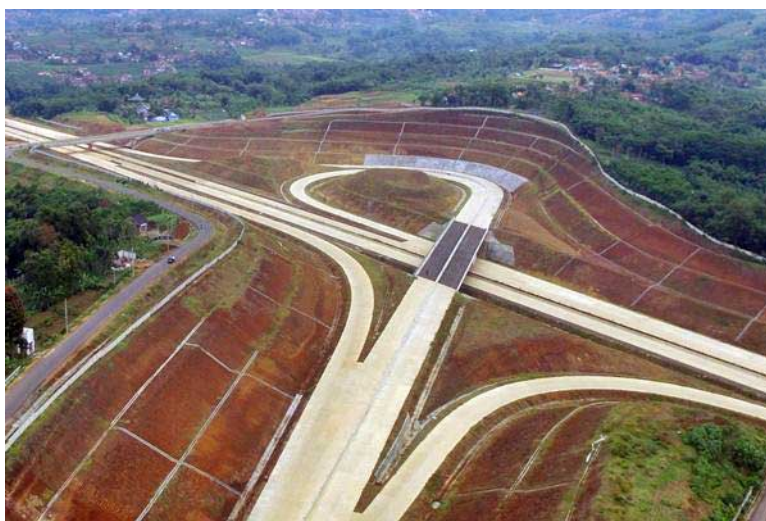
Foto aerial proyek pembangunan jalan tol Cileunyi-Sumedang-Dawuan (Cisumdawu) di kawasan Rancakalong, Sumedang, Jawa Barat, Selasa (30/5). - Antara/Fahrul Jayadiputra
